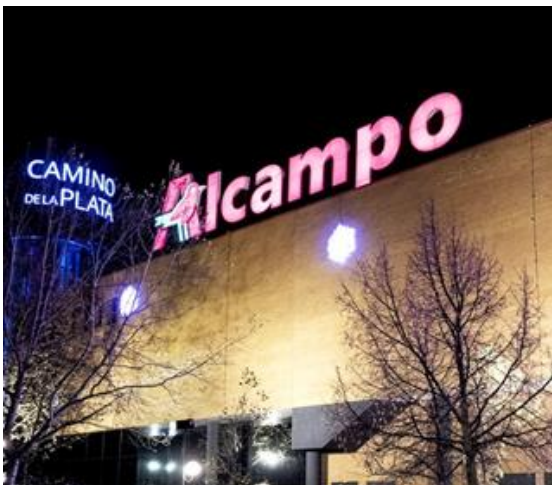
Centro comercial camino de la plata, Burgos
